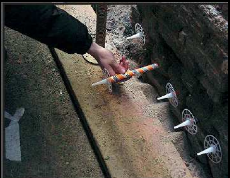
Lavori di restauro TacnoRad
