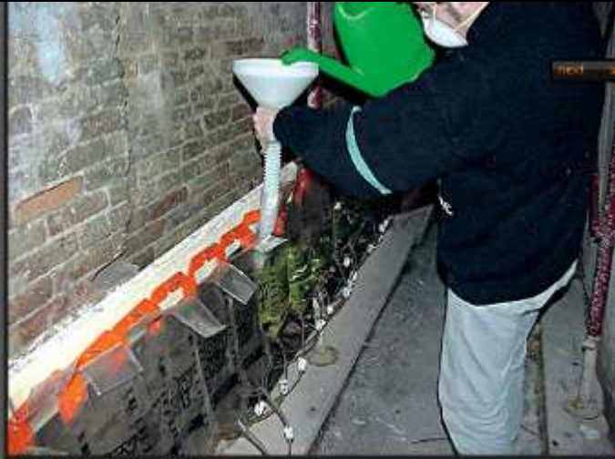
Lavori di restauro TachRed
